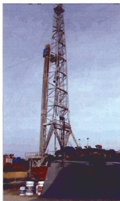
Perforación del sondeo Gaztelu#1
