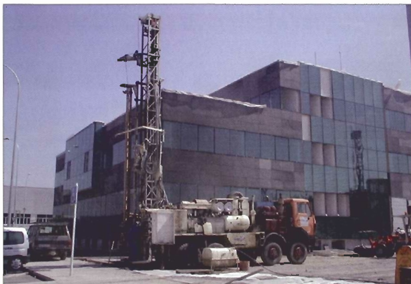
Trabajos de perforación de los sondeos de intercambio geotérmico Azterlan
