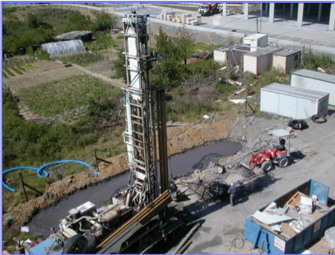
Figura 1. Labores de entubación del sondeo Azt-12
